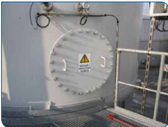
MANGATDEKSEL VOOR BETREDEN EN VOOR HET REDDEN
