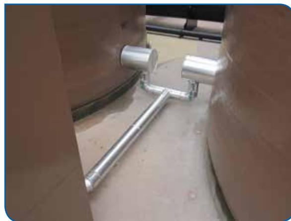
AANVOER-AFSLUITER BEDRIJFSWATER
