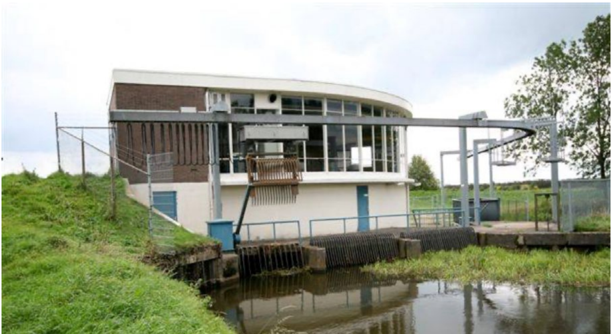
FOTO 2-1 KROOSHEKREINIGER MET FYSIEKE AFSCHERMINGEN (HEKWERK).
