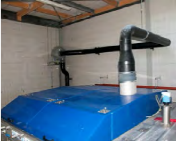
AFBEELDING 4-1 | BRONAFZUIGING OP BANDDIKKER
