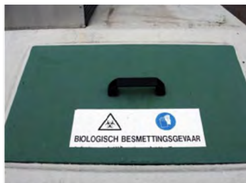
AFBEELDING 3-5 | KOELING WAAR KADAVERS TIJDELIJK WORDEN OPGESLAGEN. DE KOELING IS VOORZIEN VAN GEVAARSYMBOLLEN EN EEN GEBODSPECTOGRAM VOOR HET DRAGEN VAN HANDSCHOENEN.
