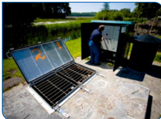
FIGUUR 2-6 VALROOSTER ONDER AFDEKKING PUT
