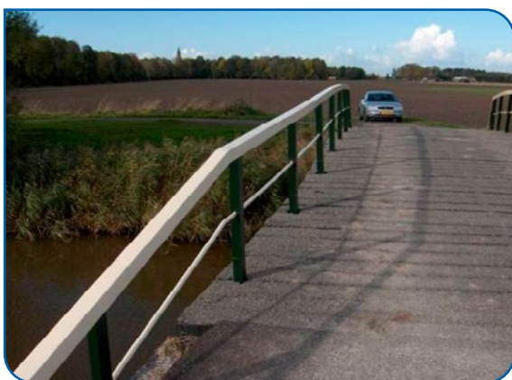
FIGUUR 2-1 HOUTEN PLANKEN MET EPOXY-AFWERKLAAG
