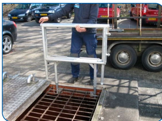
FIGUUR 2-12 MOBIEL HEKWERK: HEKWERK WORDT GEPLAATST
