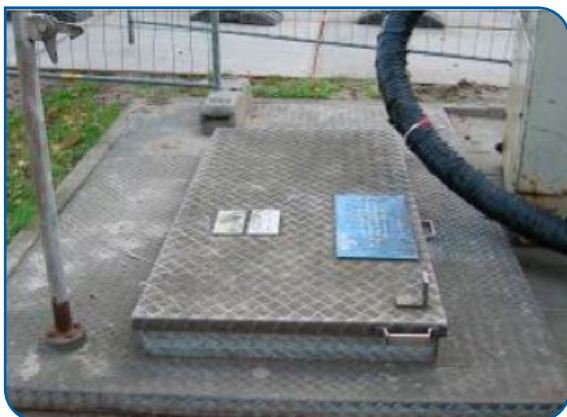
FIGUUR 2-5 STALEN AFDEKKING VOORZIEN VAN ANTI-SLIPPROFIEL
