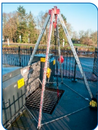
FIGUUR 2-40 VIERPOOT MET VALBLOK MET LIERFUNCTIE, STAALKABELLIER
